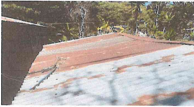
Foto 1: Sustitución de lámina por lámina troquelada
