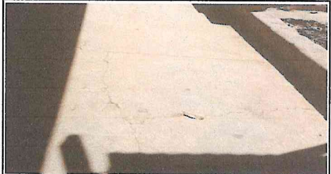
Foto 2: Reparación de piso de torta de concreto
