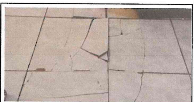
Foto 6: Sustitución de piso cerámico
