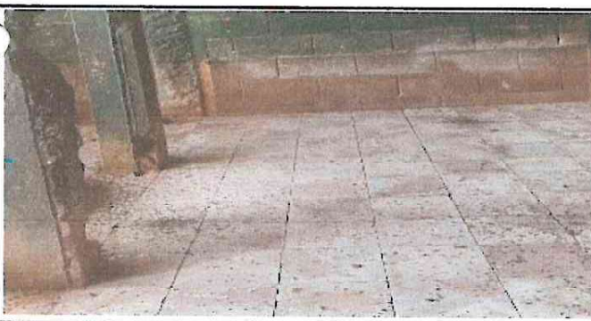
Foto 5: Reparación de piso de granito
